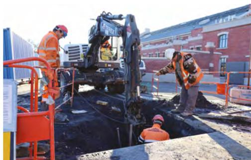
Ce sont sans contexte les travaux de voirie les plus conséquents du moment. Rue du Général Delestraint, Noréade réalise actuellement des travaux dans l'optique de créer, notamment, un réseau d'assainissement séparatif. Il s'agit de la première phase d'un chantier de réaménagement global dans le cadre duquel les riverains ont été consultés.
